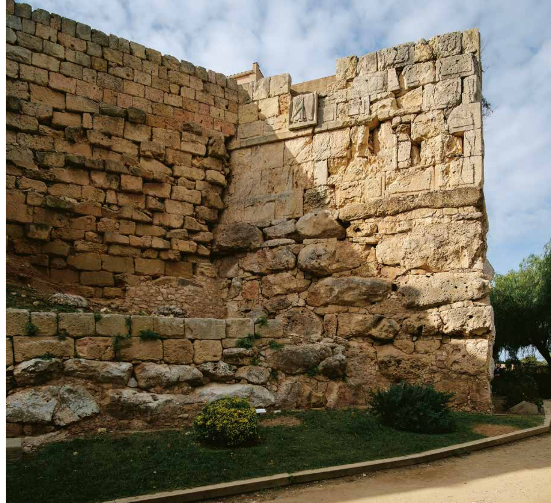
Vista actual de la torre de Minerva i del llenç adossat esfondrat l'any 1932. El parament adossat a la torre correspon al mur interior d'aquest llenç, construït en una segona fase (150-125 aC), reblert amb un farcit de toves i que va tapar l'aparell decoratiu de la torre. Ferran Gris
