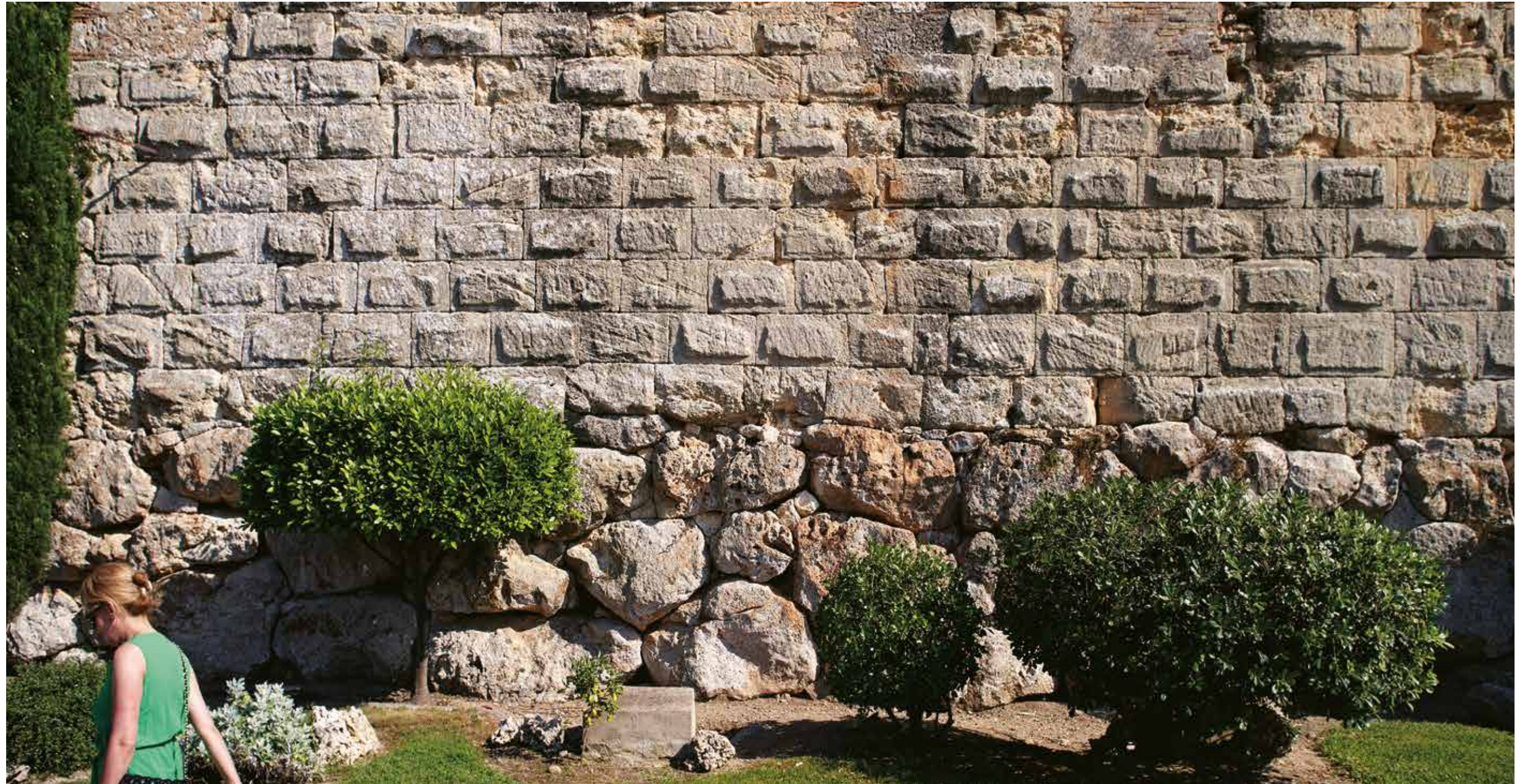
Detall de la part baixa d'un llenç de la segona fase on es mostren els carreus amb marques de picapedrers. Pepo Segura
